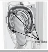
FIGURE 31. BURNER ARM & HEAT EXCHANGER
